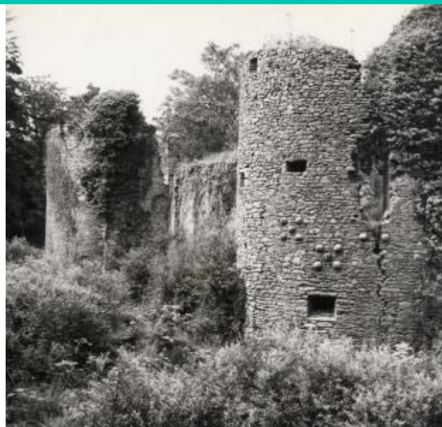
Château avant la restauration
